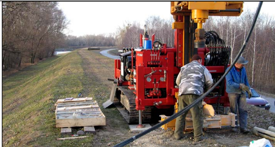
Abb. 2: Erkundungsbohrungen am Donauhochwasserschutzdamm im Auftrag der ARC-sr.
